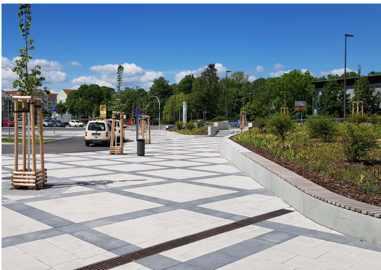
Der Blick vom alten Empfangsgebäude und Bahnsteigzugang in Richtung Vorplatz
