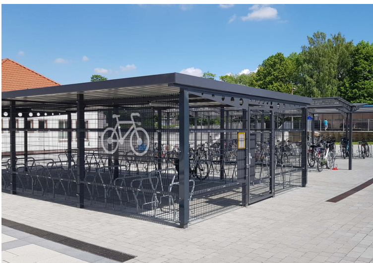
Die Fahrradabstellanlage mit frei zugänglichen und gesicherten Stellplätzen
