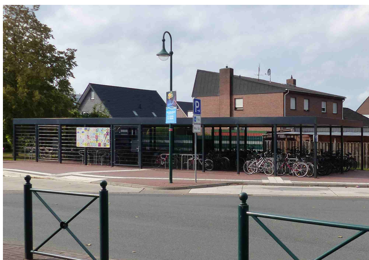
B+R-Anlagen: links Sammelschließanlagen mit RFID-Zugangssystem und Schließfachschrank mit Lademöglichkeiten für eBikes, rechts frei zugänglich
