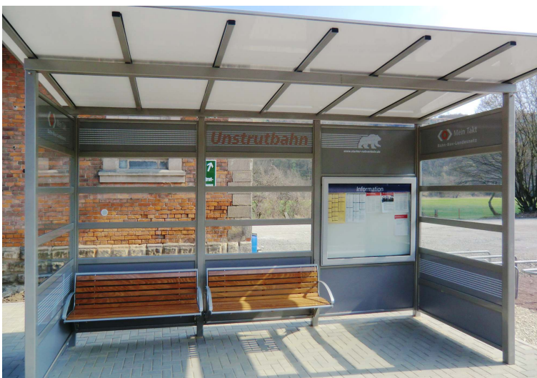
Entlang der Unstrutbahn zwischen Naumburg und Nebra wurden 2012 alle Bahnsteige erneuert; das Mobiliar erhielt eine attraktive Gestaltung
