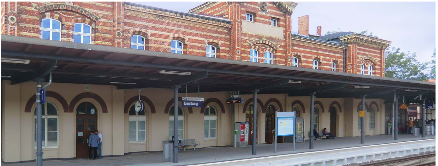
Rundum erneuert sind seit 2012 die Bahnsteige und das Empfangsgebäude in Bernburg (Saale)
