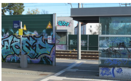
Die Lärmschutzwände haben aus dem Bahnhof Rangsdorf (Strecke Berlin – Dresden) im Zuge der teuren Modernisierung einen unwirtlichen und unsicheren Ort gemacht
